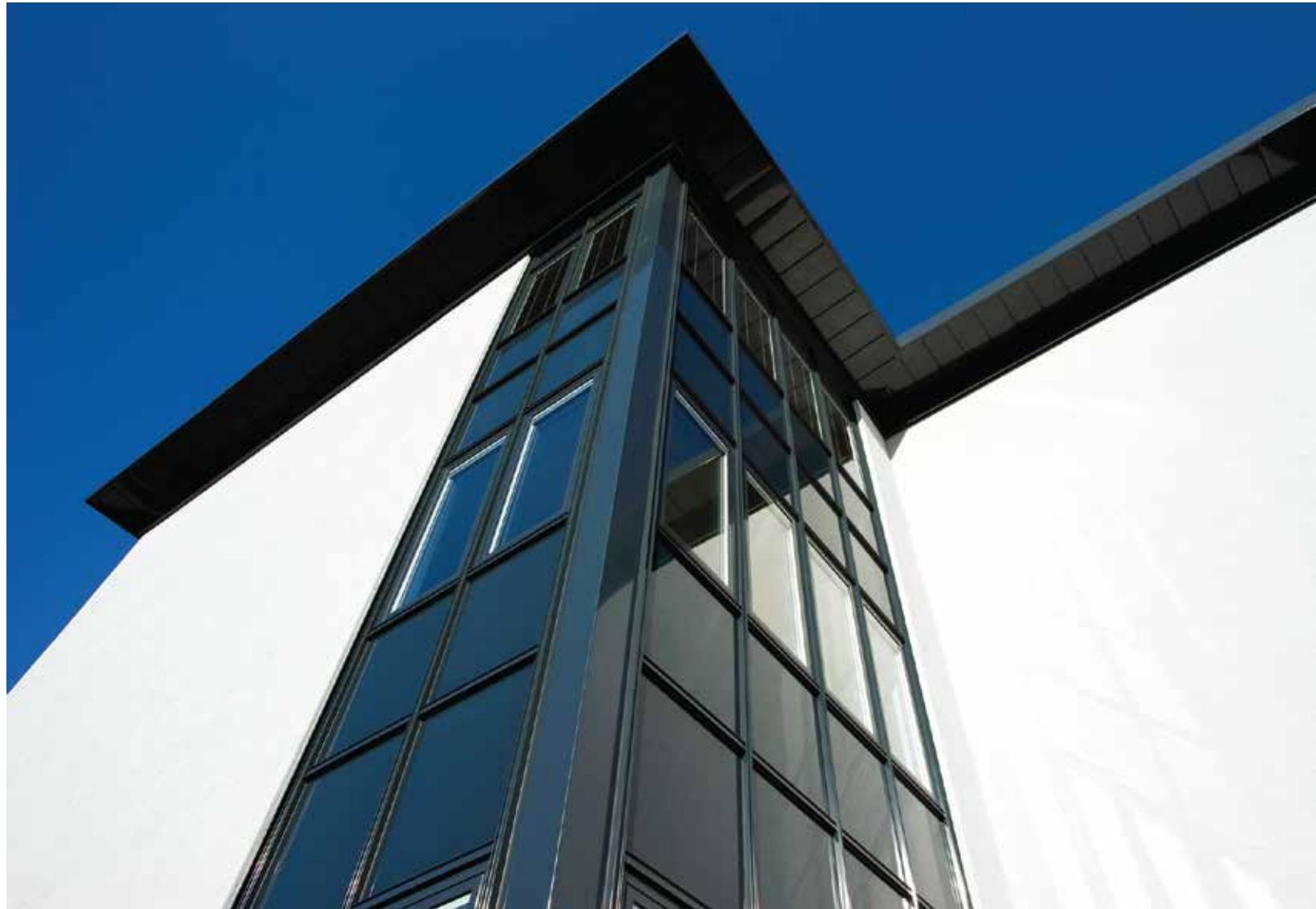
Una construcción con fachada de estructura doble instalada entre losas es la solución estándar y se realiza de forma rápida y sencilla.
