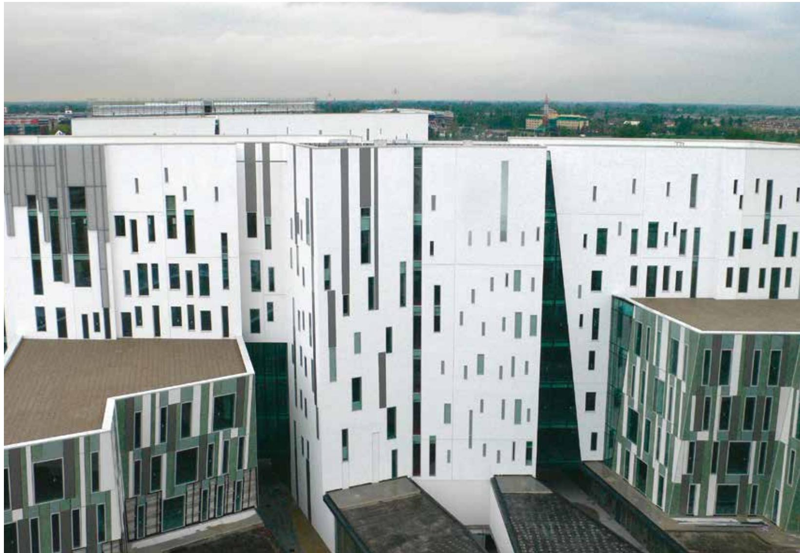
Cuando es necesario un rendimiento térmico adicional, incluida la reducción de puentes térmicos, se puede aplicar un sistema compuesto de aislamiento térmico externo (ETICS) como complemento al sistema existente.
