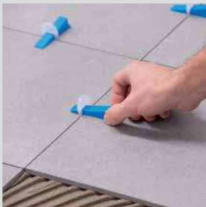
Coloque Clips KLS debajo de la cerámica e inserte las Calas KLS
